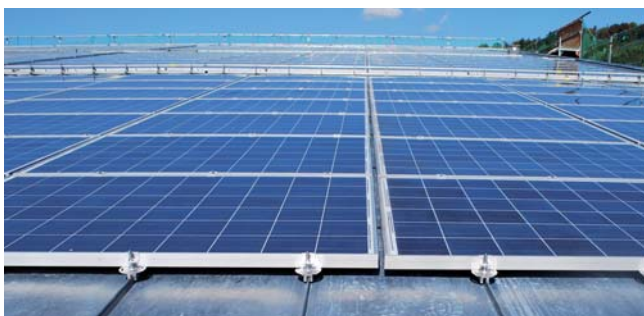
Liegende Montage der Module mit dem PV-Kit
